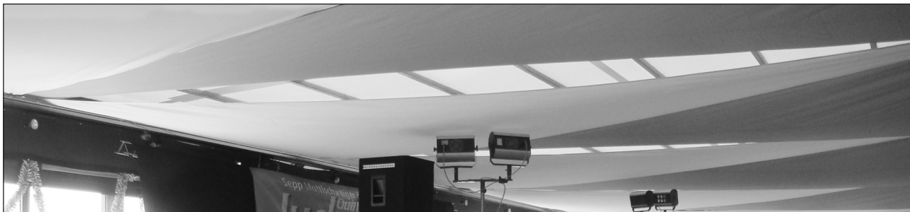
Das Stoff-«Dach» der illegal überbauten Südterrasse – an den Wärmedämmqualitäten darf gezweifelt werden.
